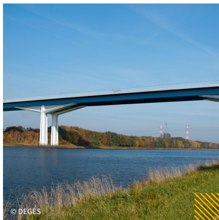
«Rader Hochbrücke», Rendsburg: Unter der technischen Federführung von Implenia wird die Brücke in Stahlverbundbauweise erstellt. Sie spielt eine wichtige Rolle für den Verkehr von und nach Dänemark und Skandinavien.
