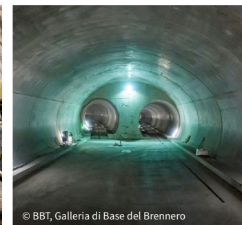
© BBT, Galleria di Base del Brennero
