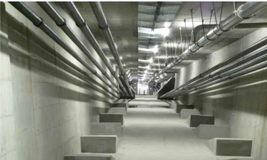
Hohlkastenüberbau mit externer Vorspannung
