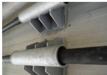
Stahlteil mit innenliegender Umlenkchülse
