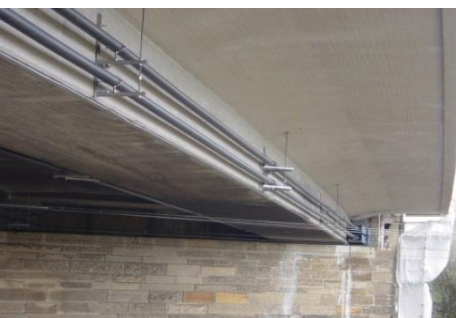
Hohlkastensteg mit externen Spanngliedern
